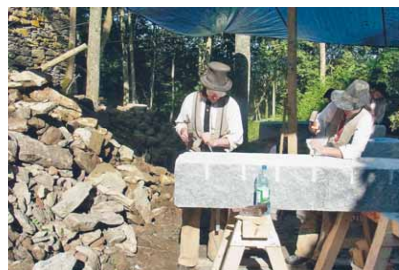
Mit den vorher vor Ort geschmiedeten Werkzeugen bearbeiteten die Wandergesellen Granit für Abstützarbeiten. Foto: Posern
